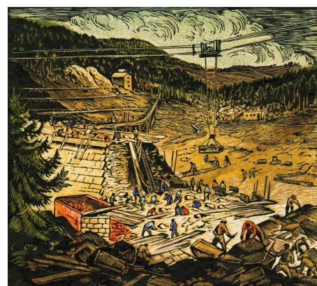
Stavba Husinecké přehrady
